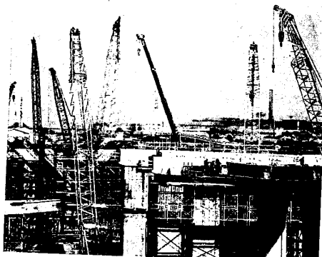
Pekerja sedang membangun jalan tol akses Priok
