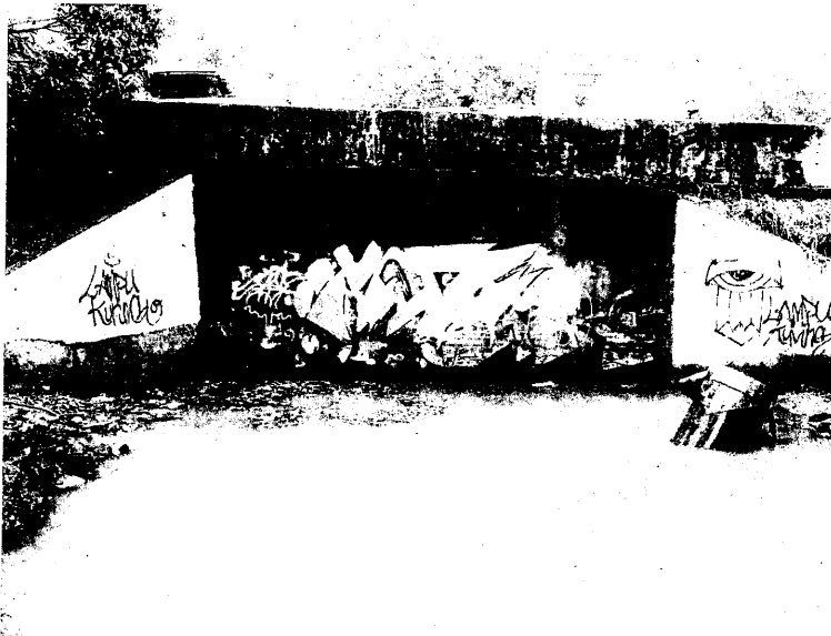
Kondisi jembatan di Jalan T.B. Simatupang, Jakarta Selatan, yang ambles sudah dirobohkan, kemarin.
