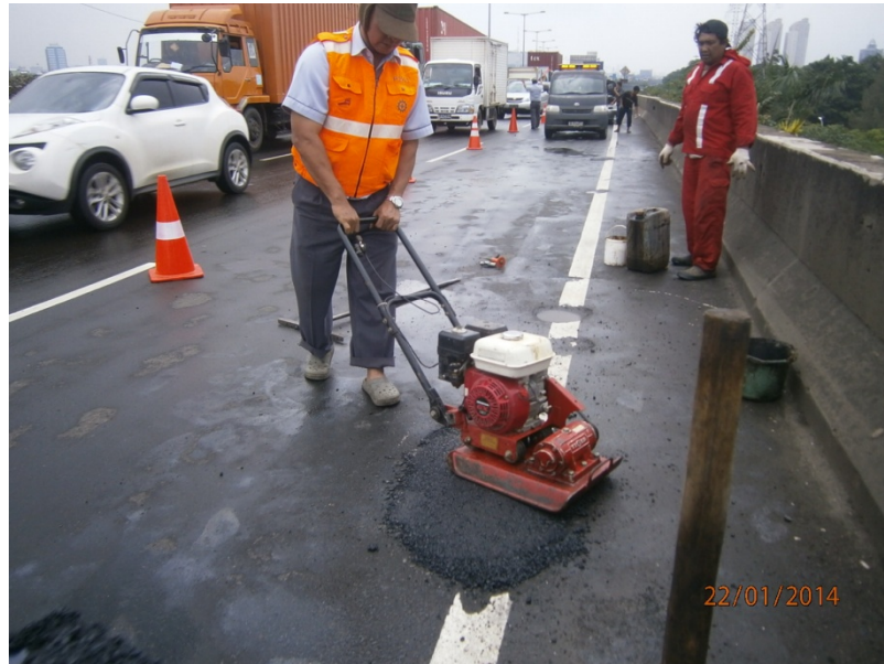
Petugas tengah melakukan perbaikan jalan berlubang di tol Cawang-Tanjung Priok-Pluit.
