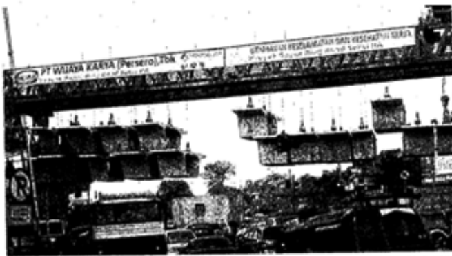
Jalan Bogor Outer Ring Road (BORR) 2A saat awal pembangunan. Rencananya, April mendatang, jalan tol ini sudah bisa digunakan.
