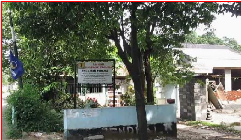
Clearing sisi Utara Jalan Bango (Rencana Jalan Tol Layang)
