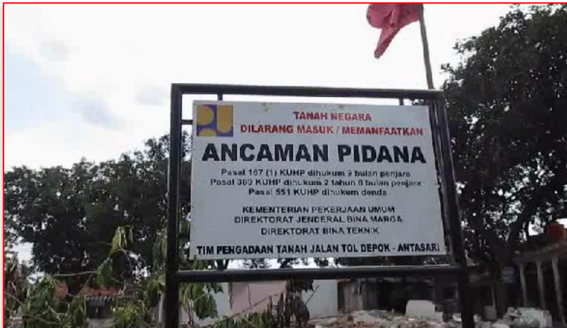
Clearing Jalan Intan sisi Utara (Belakang Highscope)
