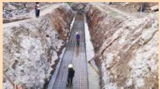
Box Culvert untuk irigasi STA 27 + 830 Box culvert for irrigation STA 27 + 830
