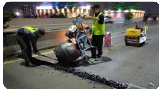
Lokasi perbaikan Expansion Joint rutin dilaksanakan spot by spot pada lokasi KM 17.600 Ruas Harbour Road .
