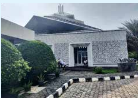
Tempat Ibadah Praying Room
